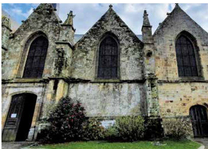
Contrefort avant travaux
