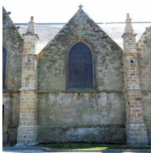
Contrefort après travaux
